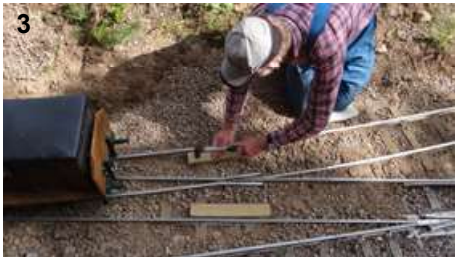
Per Ljungberg fann för gott att spika fast styrråler av trä på det provisoriska arbetsspåret vid Rustansbergs station.
