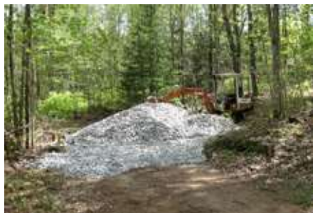
Makadamutfyllnad för att jämna väg. Rolle kapar betongpelare för fundamentet.
