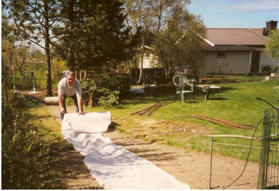
Vägmattan läggs ut.
