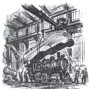
Modernisering i lokverkstaden.
