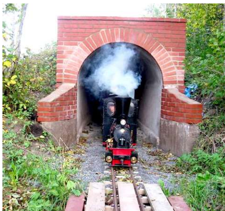
Rökfylld tunnelpassage. Foto Rolle.
