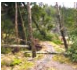
Infarten till Rustansberg är tämligen väl blockerad med ett antal träd. Den stora rotvältan i bildens mitt har dessutom underminerat banvallen vid Vattenlösa Sjön.
