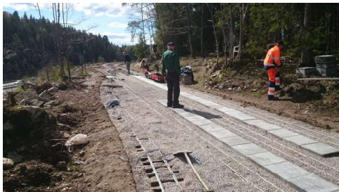
Betongplattorna kommer på plats.
