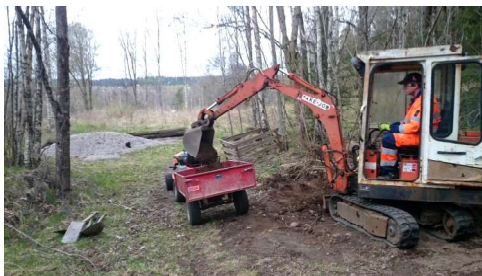
Anders gräver fylladsmaterial.
